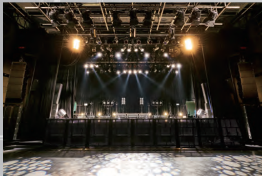
■ ホールの左右にCODA AUDIOのラインアレイシステムが吊られている。 3-Wayフルレンジ・ラインアレイモジュール“AiRAY”、 センサーコントロールド・サブウーファー“SCV-F”、 センサーコントロールド・ベースエクステンション“SC2-F”
