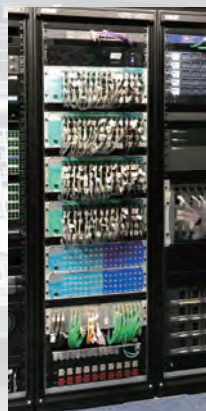
■ コントロールルームのラック一式
