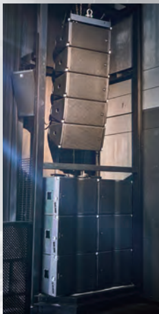
■ ホールの左右にCODA AUDIOのラインアレイシステムが吊られている。 3-Wayフルレンジ・ラインアレイモジュール“AiRAY”、 センサーコントロールド・サブウーファー“SCV-F”、 センサーコントロールド・ベースエクステンション“SC2-F”
