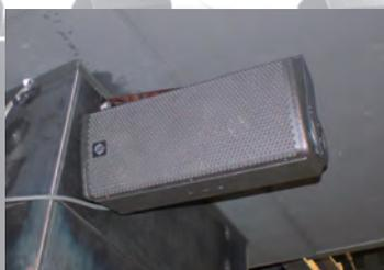
■ 柱裏の音質をさらに向上させるため、HOPS8iをディレイスピーカーとして設置。
