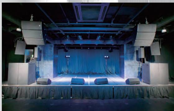
■ メインスピーカーとしてフライングで設置された2×3基のAPS。ウェッジモニターにはG512-96、サブウーファーとして2基のU4、インフィにG515-96を採用。
