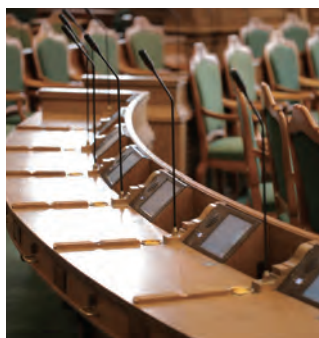
埋め込みユニットにモニターをはめ込み
